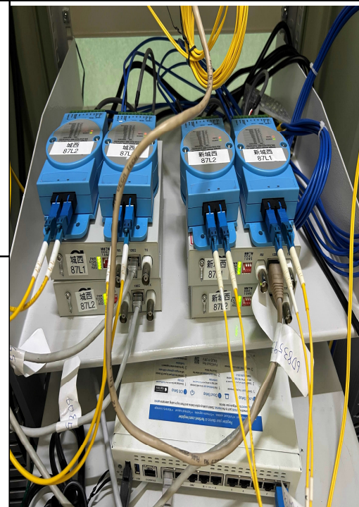
87L 電驛 直通光纖轉E1轉換器
