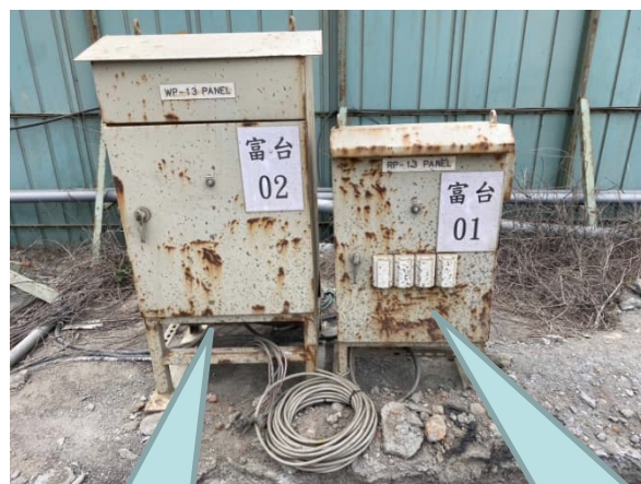
RP盤 (低壓110V)
